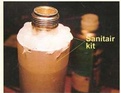
Aanbrengen van sanitair kit op de flens. Op de buis moet nog een dunne laag kit aangebracht worden.
